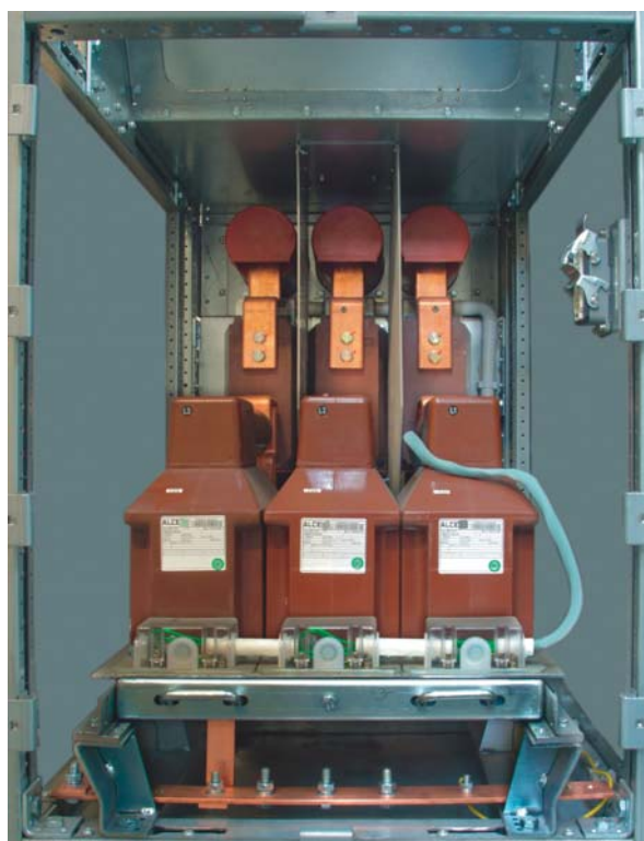
Przekładniki napięciowe w polu liniowym.
